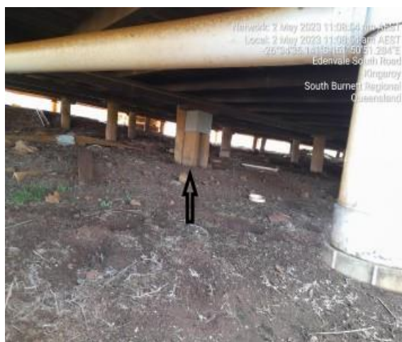
Concrete block in lieu stump.
